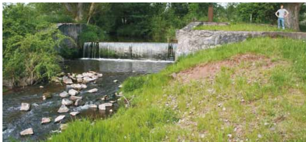
Unüberwindbares Querbauwerk im Mündungsbereich des Imsbaches in die Prims.
